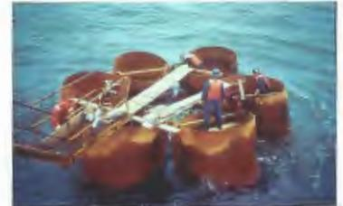
Construction of large diameter battered drilled concrete shafts for approach spans (1994-1995) / Construction des piles sur pieux en béton battus et forés à large diamètre pour les travées d'approche (1994-1995)
